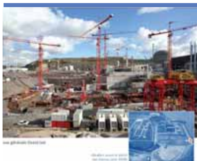
Travaux de construction de EPR de Flamanville en octobre 2008 (crédit EDF)
